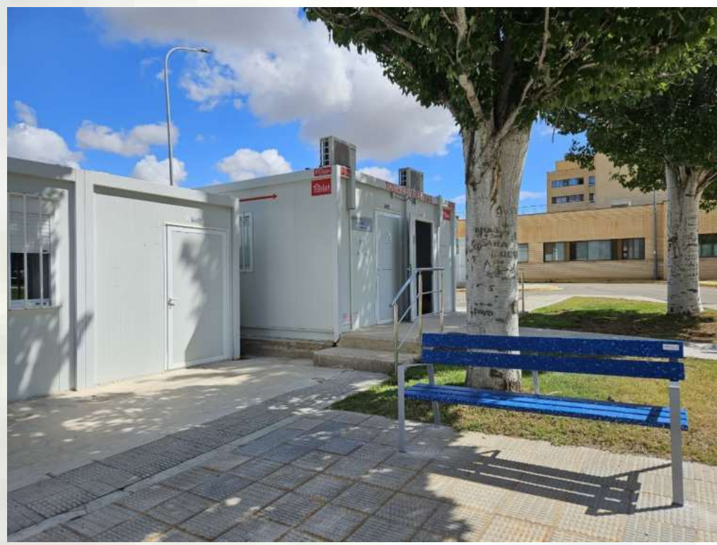
Exterior del servicio de Urgencias
