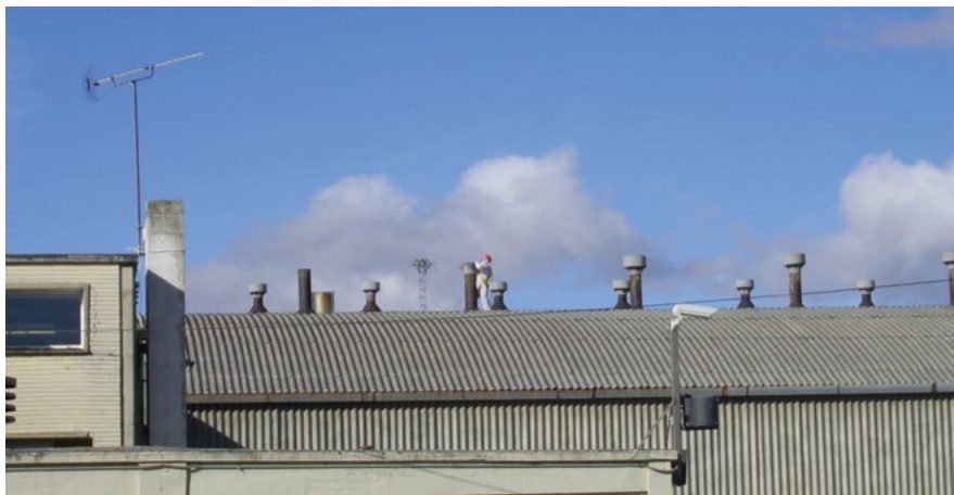
Retirada de chimeneas de fibrocemento en cubierta de nave industrial.
