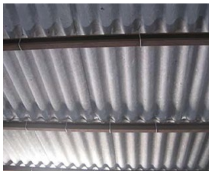
Vista inferior de cubierta de fibrocemento con estructura metálica en buen estado de conservación.
